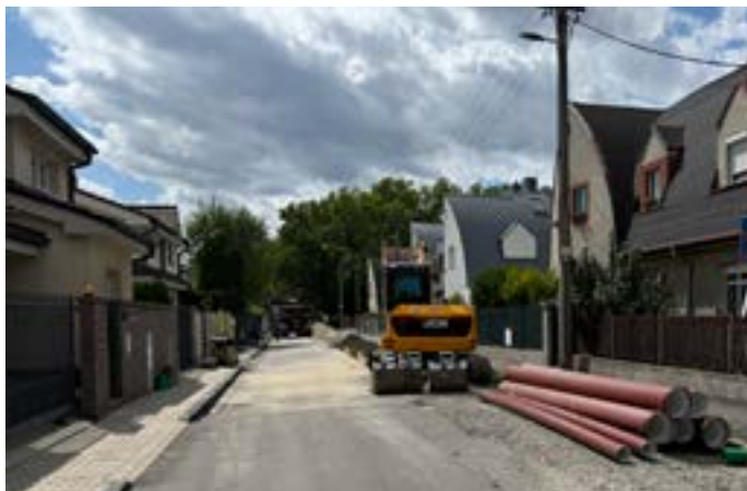
Oprava kanalizácie na Trnávke (Okružná, Jasná)
