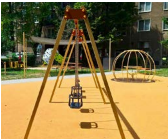
Zrekonštruovaný vnútroblok Gemerská
